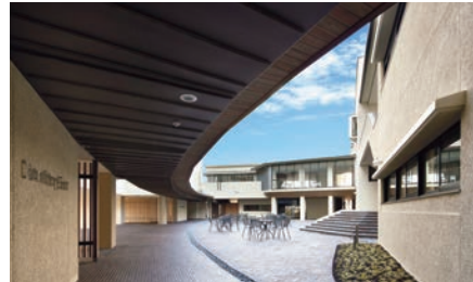
寮棟 (左) 教室棟 (右)
