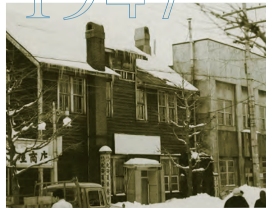
北海道栄養学校となった 旧事務所
