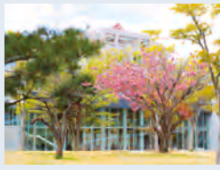
工学部中央棟
