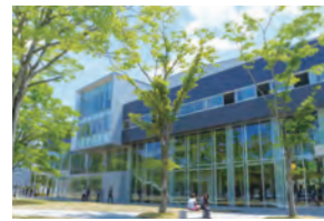
9 工学部中央棟
